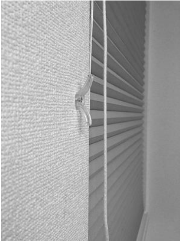
両面テープで仮止めをします。
