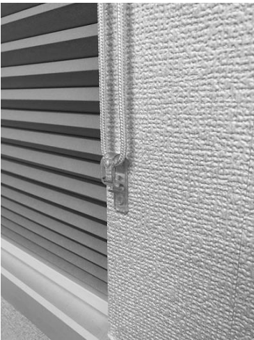
コードを張った状態で、両面テープで仮止めをします。
